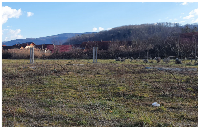
Nadzemni dio ukopane konstrukcije preljeva glavnog kolektora koji je izgrađen u cijelosti ili u svojem dijelu na predmetnoj čestici zemljišta - odzračnici i reviziona okna.
